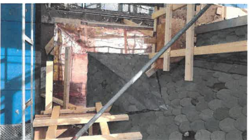
Alle skifer- og beslagarbeider er basert på gjentagelse av de opprinnelige løsningene, både i forhold til materialbruk og teknikker for bearbeiding og infesting. Her fra tårnets takfot og hjørne mot sydøst, sett ovenfra, med nytt sprangblikk.
